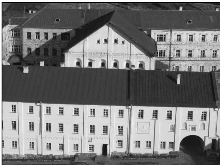
Наместнический (нынешний братский) корпус и северный дворик
