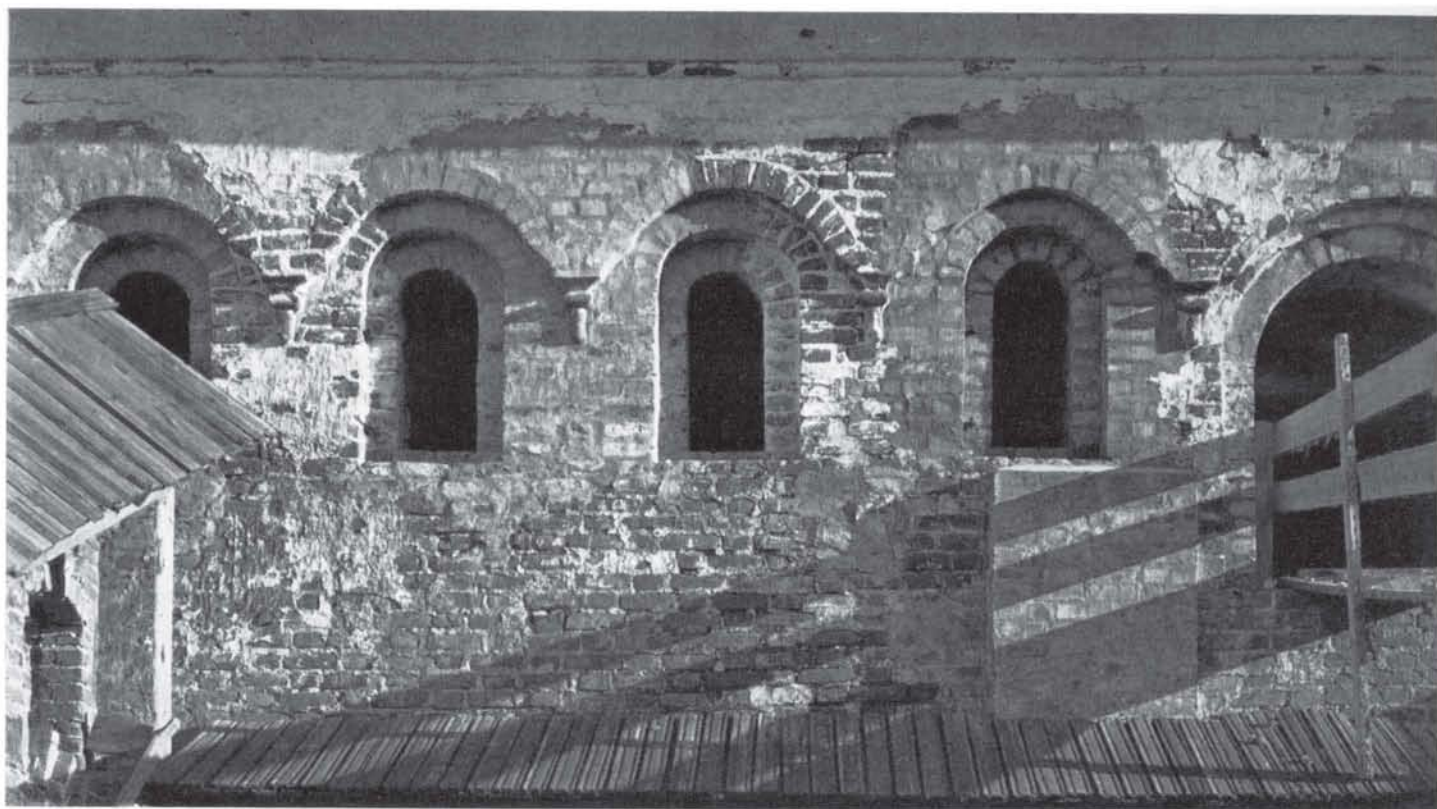
64 Рутядная палата. XVII (?) в. Фрагмент се- верной стены в процессе реставрации. Выполнена по проекту О. Д. Савиц- кой. ВИИРК. 1978
