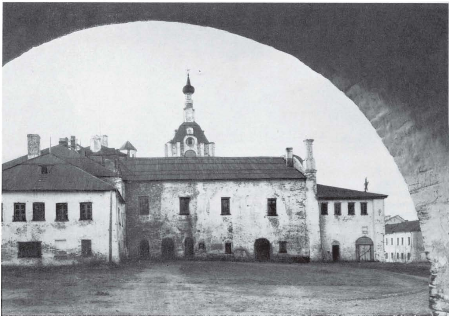
5 Комплекс Трапезной палаты. 1552—1557 гг., XIX в. До реставрации
